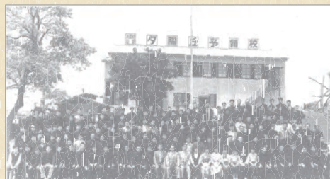
昭和31年(1956年) 完成時の木造校舎
